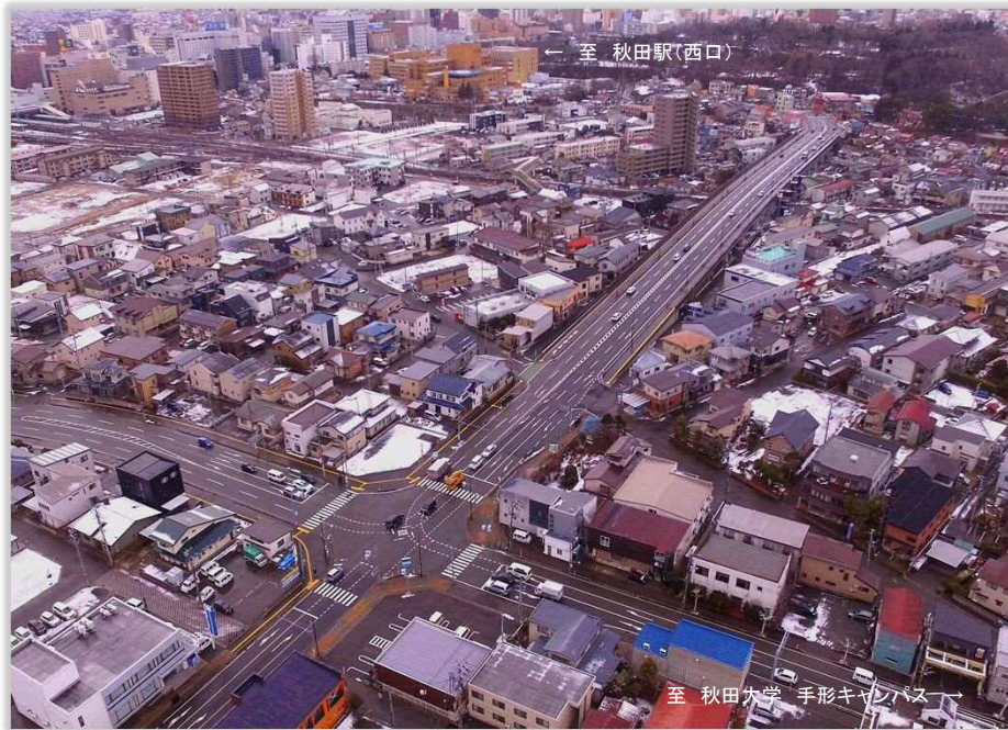
千秋広面線 手形陸橋 完成 (秋田市・令和元年11月)
