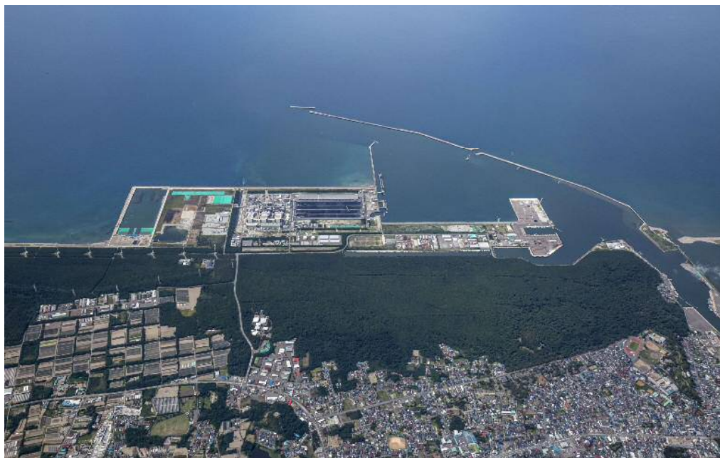
能代港全景(令和元年8月撮影)
