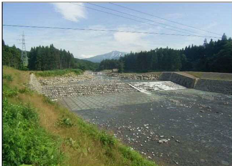
《鳥海山噴火の影響地域にある白雪川で、現地発生材の玉石張りや魚道の設置など環境に配慮した砂防床固工（縦断侵食の防止）》
