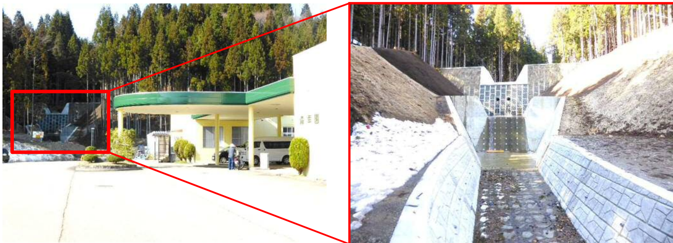
《要配慮者施設を保全するため、砂防えん堤を施工した北秋田市・森幸苑沢》
