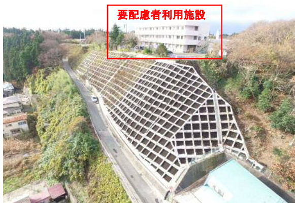
《要配慮者利用施設や市道をがけ崩れから守る法枠工》 《男鹿市・女川地区》
