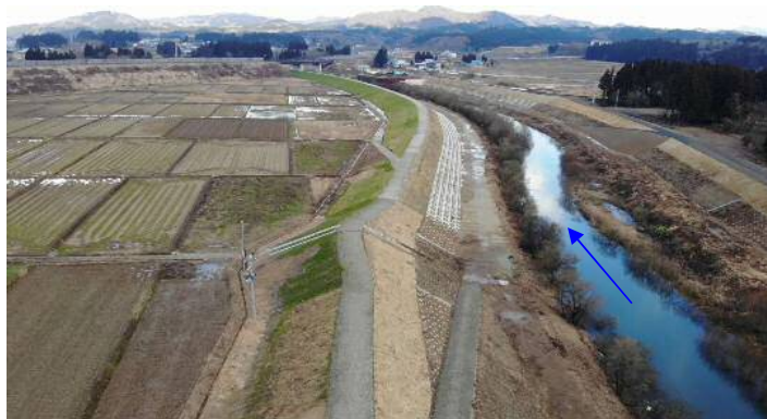
復旧工事完了
