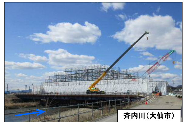
《JR橋梁架替工事(桁製作中)》
