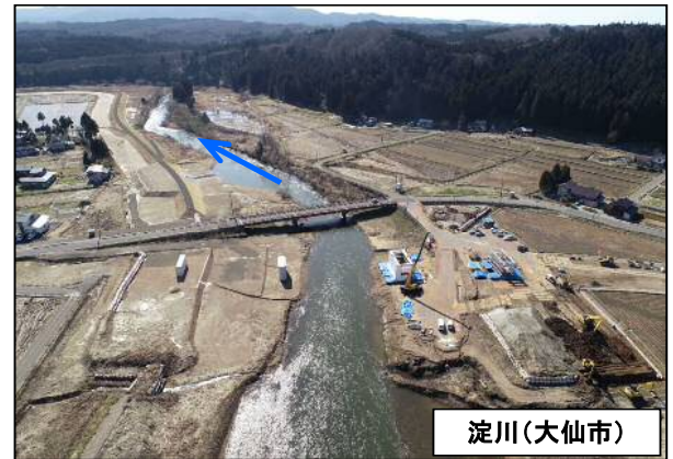
《川原橋架替工事(下部工施工中)》
