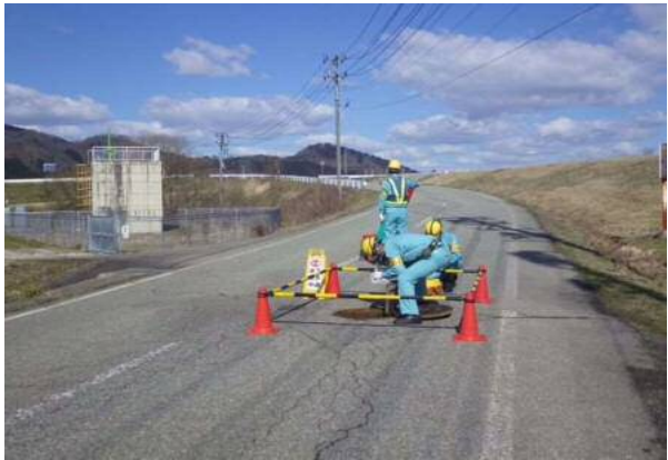
マンホールの点検
