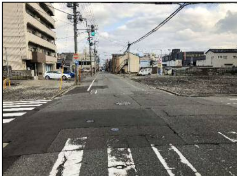
【道路拡幅・無電柱化による防災性能の向上】 3・4・14川尻広面線 秋田市大町地内 (事業用地取得状況)
