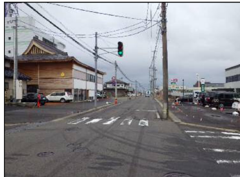
【都市空間における防災性を確保する街路事業】 3・4・4停車場栄町線 由利本荘市裏尾崎町地内 (工事進捗状況)
