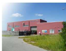
天王東排水機場
