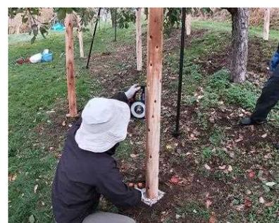
図11 支柱の鉛直確認
