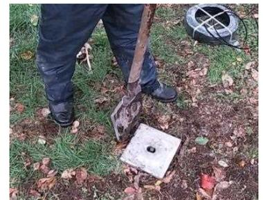
図7 コンクリート板埋設位置に目印
