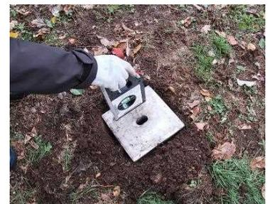
図8 コンクリート板の水平確認
