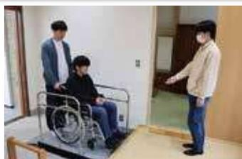
玄関の段差に対応する段差解消機
