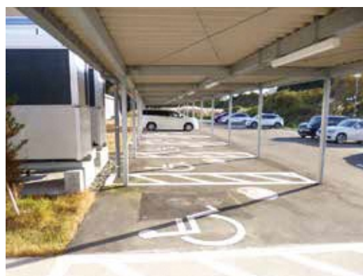
荒天の日の乗り降りに配慮されたカーポート付き車いす駐車場
