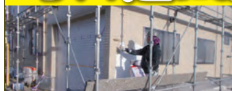
外壁 工事内容
