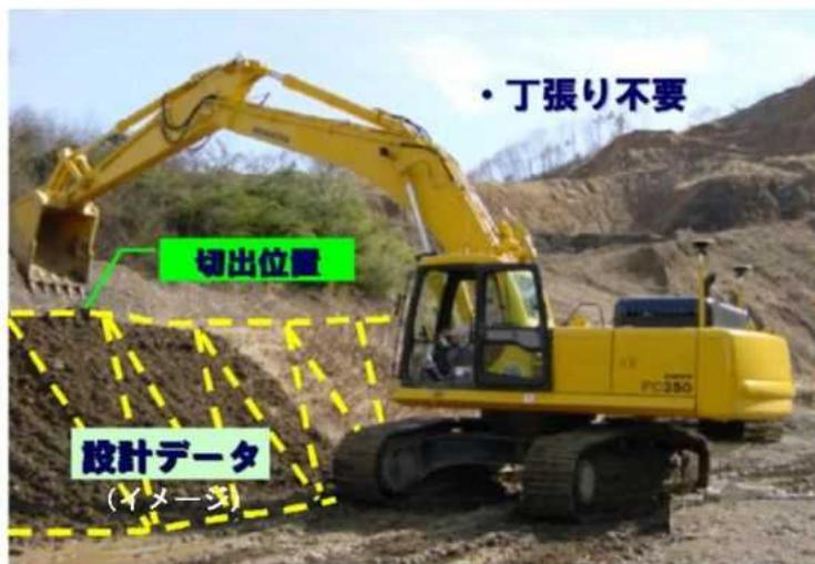
※実施する施工プロセス：② 3次元設計データ作成
