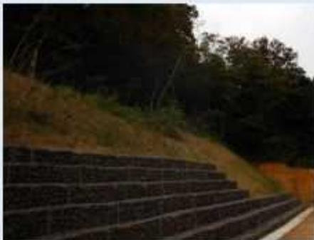
・施工後法面保護の必要性がある場合は、法面一段の施工後、TS等光波方式を用いた出来形管理等で断面管理を実施することで、法面ごとの面管理に比べて効率的に管理できる。
