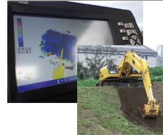
ICT建機の 施工履歴データ
