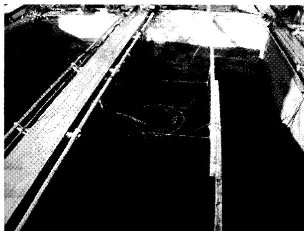
写真1 エアリフト装置
