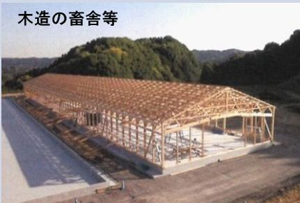
木造の畜舎等 | (1)一般流通材を用いた<br>低コスト畜舎等の試設計 | (2)低コスト設計による<br>畜舎の実証施工・監理<br>(3)既存部材とRC・鉄骨造との組合せ利<br>用に必要な接合部の安全性検証 | (4)実証データ等とりまとめ<br>利用モデルの確立と提案 | 非住宅分野<br>需要創出 |
