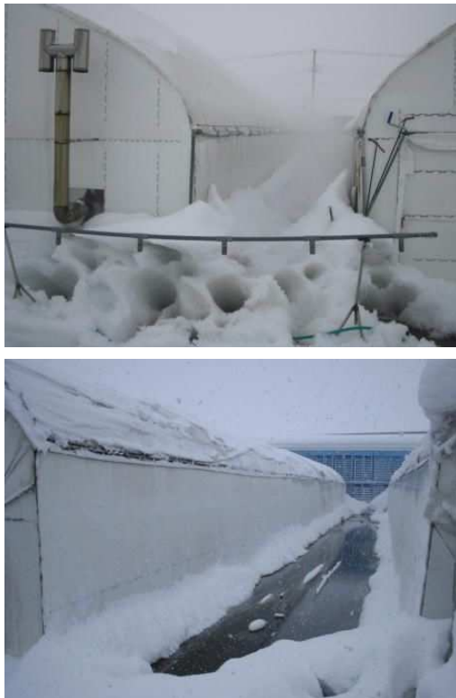
【地下水利用による消雪で冬期の除雪労力を軽減】
