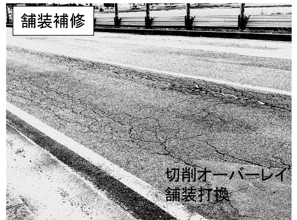
国道285号 上樋口工区 (五城目町)
