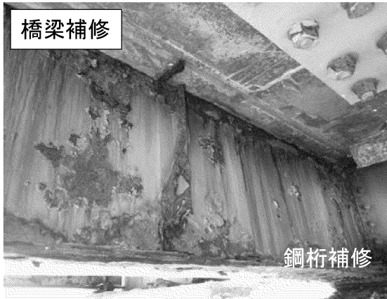
(一) 富根能代線 富根橋 (能代市)
