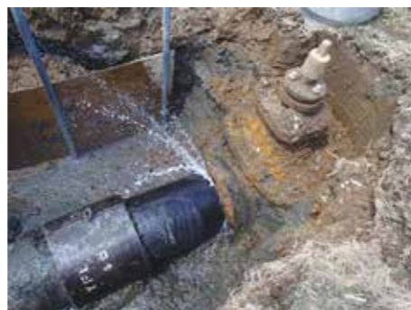
突発事故によるパイプラインからの漏水
