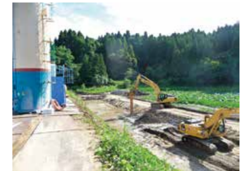
老朽化したため池の改修
