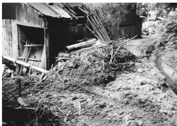
平成23年土砂流出状況
