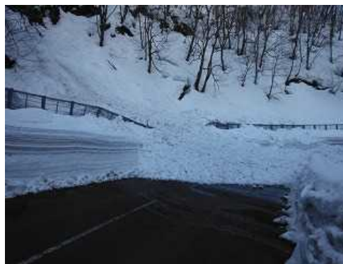
平成 26 年 3 月に国道 105 号で発生した雪崩状況
