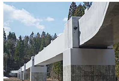
斎藤川水路橋（施工後）
