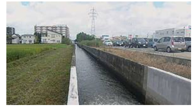
旭川左岸幹線用水路（施工前）
