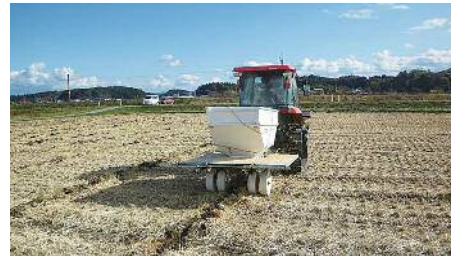
モミガラ補助暗渠の施工状況 （湯上市）
