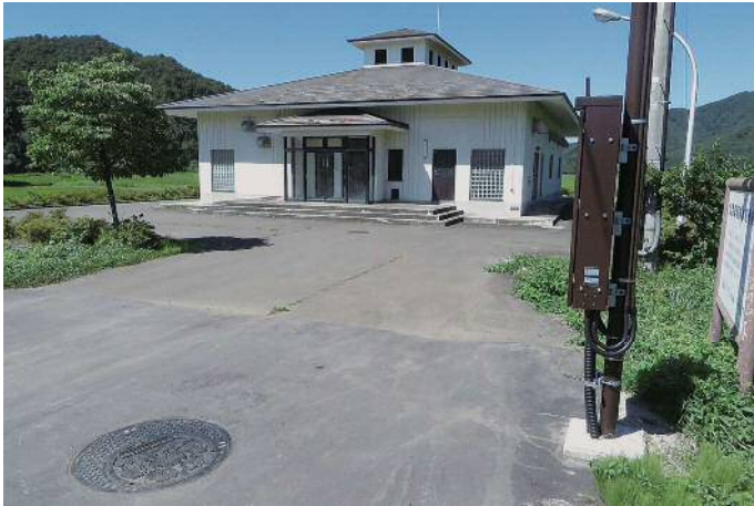
農業集落排水処理施設の整備 沢尻地区（大館市）
