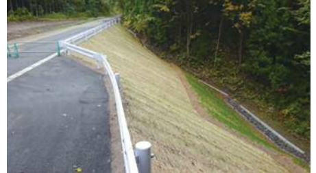
地すべり防止施設の完成状況 (鹿角市 堪忍沢)
