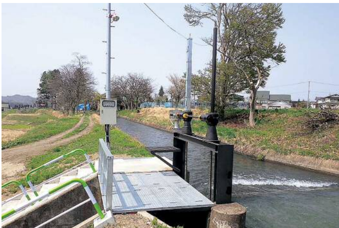
ゲートの更新（電動化）湯沢3地区（湯沢市）
