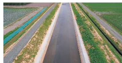
着工後（大宮川幹線排水路）
