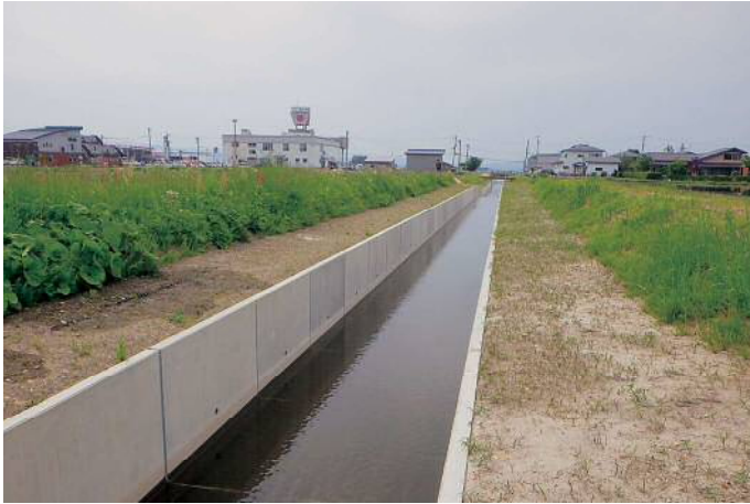
幹線用水路の改修 平鹿平野二期地区（横手市）
