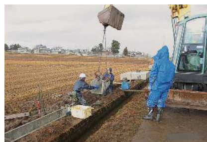
水路の更新 樽見内地域農地・水・環境保全組織（横手市）
