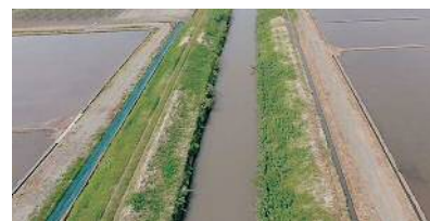
着工前（大宮川幹線排水路）
