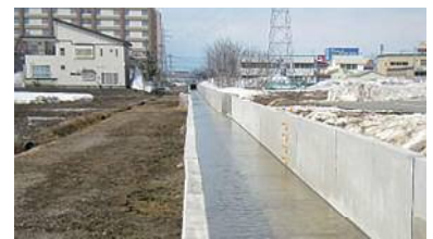
旭川左岸幹線用水路（施工後）
