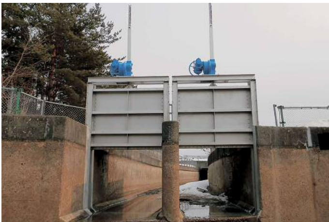
ゲートの更新 能代1期地区（能代市）
