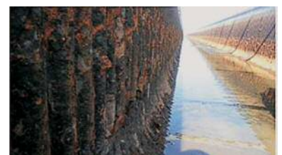
老朽化している支線用水路
