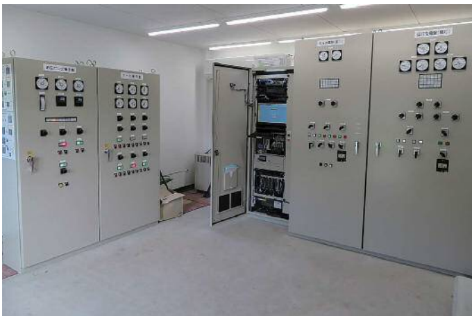
ダム施設の更新 芋川地区（由利本荘市）
