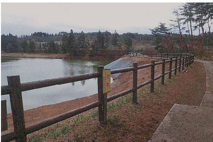
ため池転落防止柵の更新 三種2地区（山本郡三種町）
