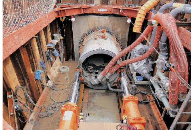
【用排水施設整備】
