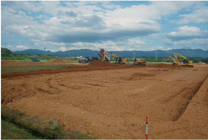
客土整備 鹿角第二地区（鹿角市）
