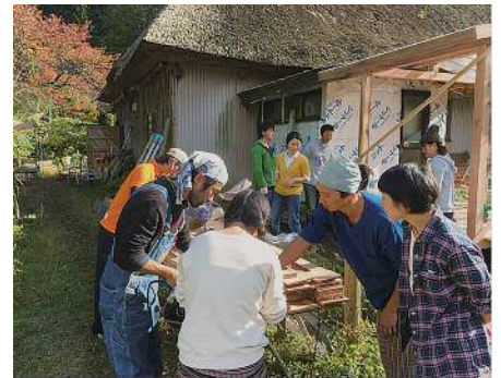
「エコトイル」のリフォーム体験
