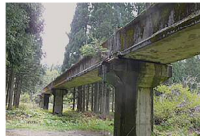
斎藤川水路橋（施工前）
