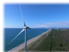
風の松原風力発電所
