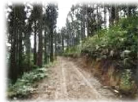
森林作業道の整備
