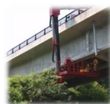
橋梁点検作業
