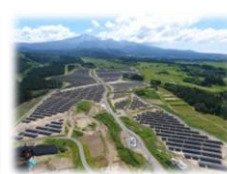
AKITA NIKAO 発電所（太陽光）
