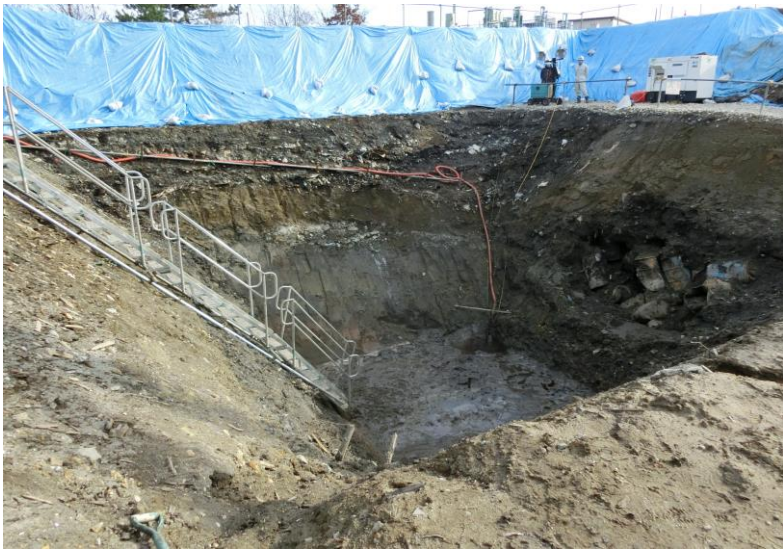
11月22日 掘削完了(深さ 約 9.0m)
