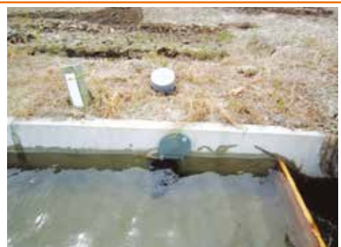
取水口付近を堰き止め水量確保
