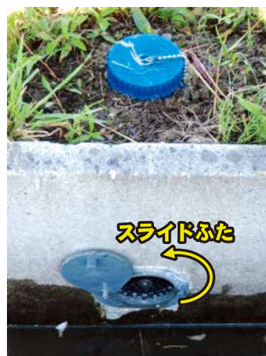
上流側の注水口
