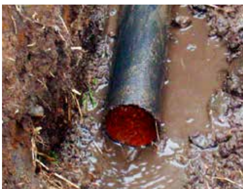
暗渠管内の鉄の集積
