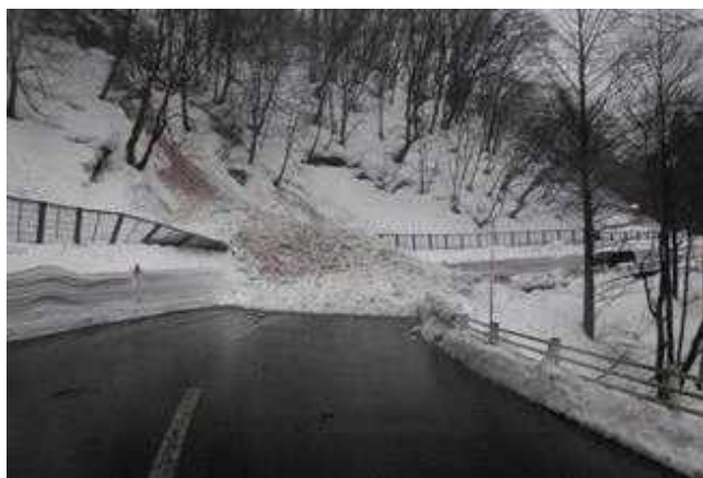
（H29. 2. 17雪崩発生状況）
