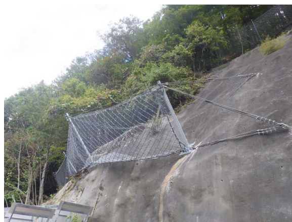
（国道105号 令和6年度 落石防護柵工）
