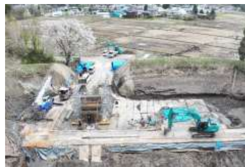
家の後地区 取水施設工事
