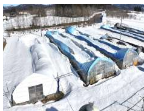
（雪害）大館市 比内地鶏鶏舎の倒壊
