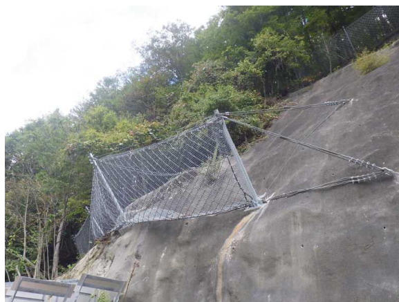
(国道105号 令和6年度 落石防護柵工)
