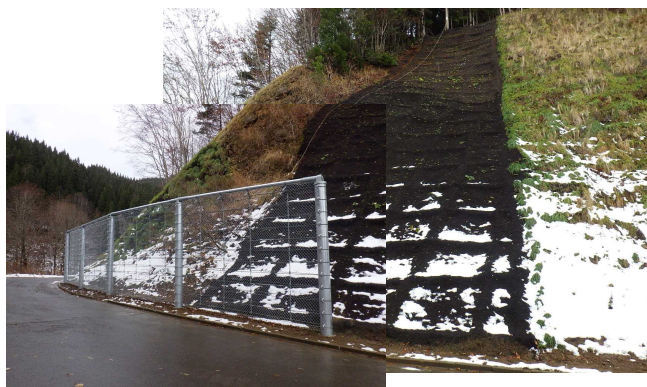
(県道比内森吉線 令和6年度 法枠工、 落石防護柵工)
