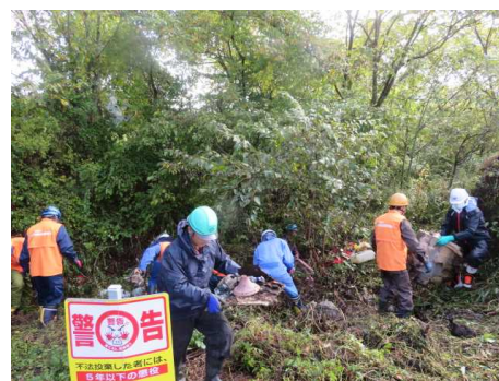
(不法投棄廃棄物撤去作業)
