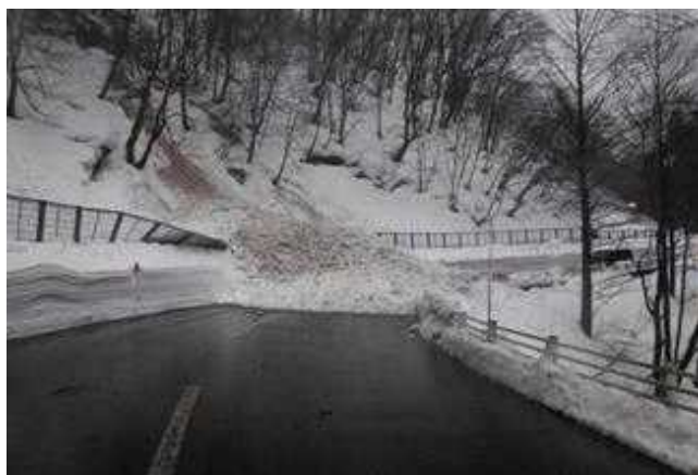
(H29. 2. 17雪崩発生状況)
