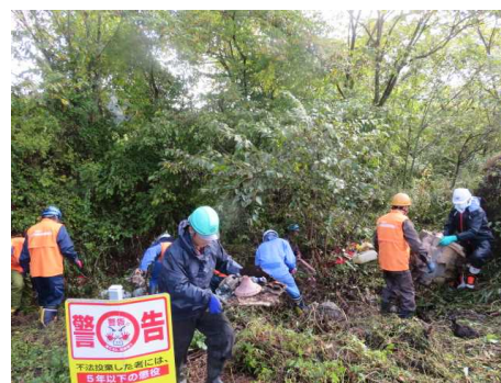
(不法投棄廃棄物撤去作業)
