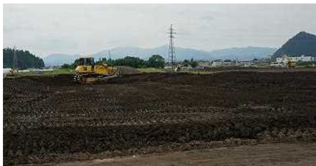
(ほ場整備事業 整地状況)
