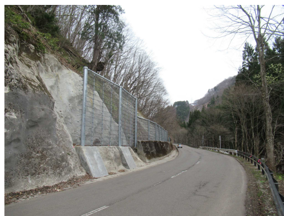
（国道105号 令和4年度 落石防護柵工）
