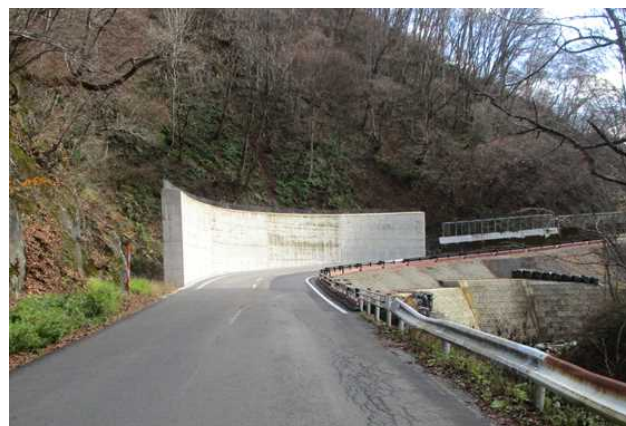
（令和4年度 スノーシェッド山側下部工）
