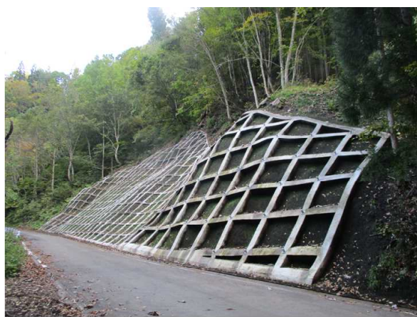
（県道比内森吉線 令和5年度 法枠工）
