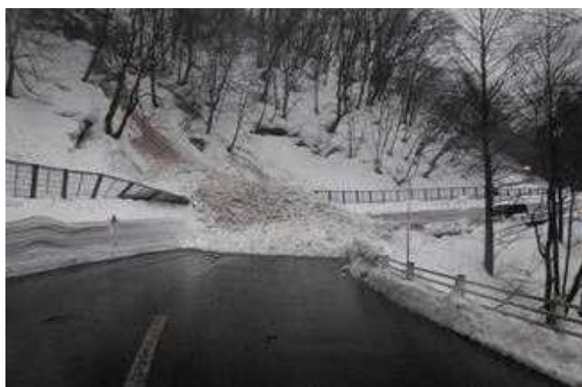
（H29. 2. 17雪崩発生状況）
