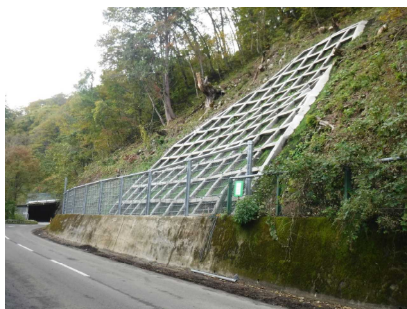
国道105号 令和3年度 落石防護柵工
