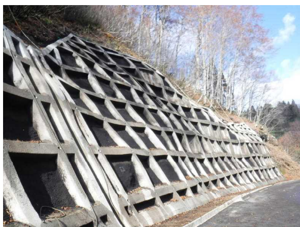
県道比内森吉線 令和3年度 法枠工
