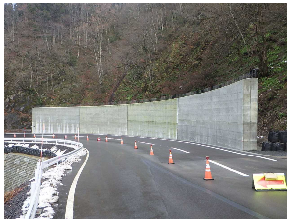
令和3年度 スノーシェッド(山側下部工)
