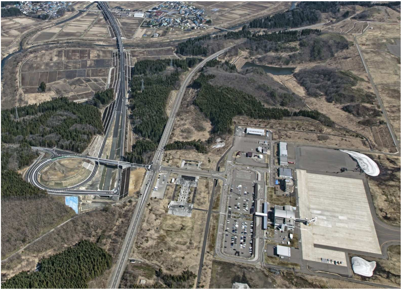
日沿道 大館能代空港IC と 大館能代空港（H30. 3大館能代空港IC～鷹巣IC間開通）
