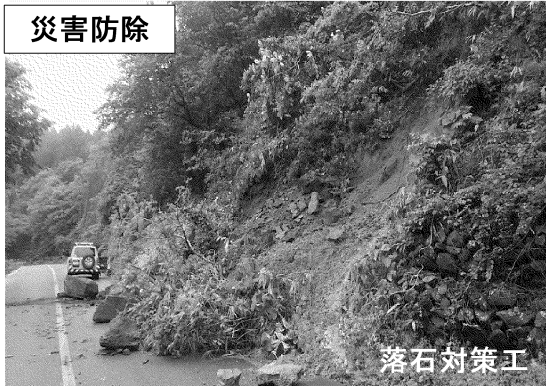
男鹿半島線 加茂青砂1号工区 (男鹿市)
