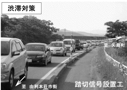
国道108号 黒沢工区 (由利本荘市)
