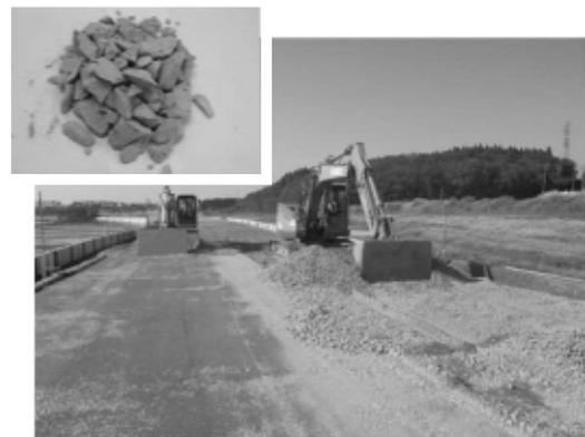
道路の路盤材、構造物基礎材などで使用されています。
