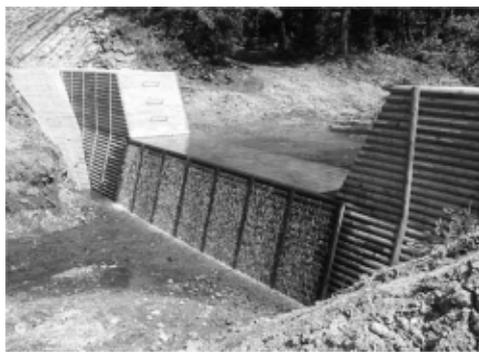
残置型型枠材、木柵などに使用されています。
