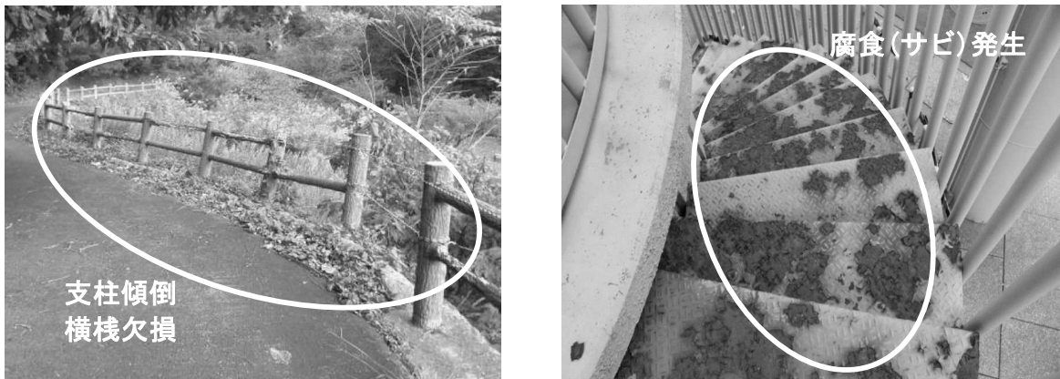
転落防止柵の取替 [小泉湯公園]
