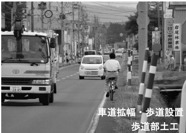
国道108号 薬師堂工区 (由利本荘市)
