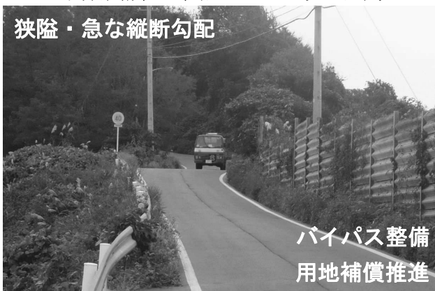
国道101号 浜間口バイパス工区 (男鹿市)
