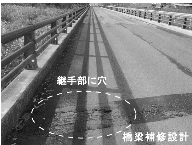
国道398号 久保橋（湯沢市）
