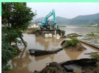
災害復旧作業
