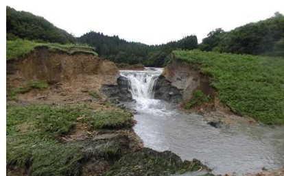
平成29年の豪雨災害で決壊した杉の沢ため池 (大仙市)
