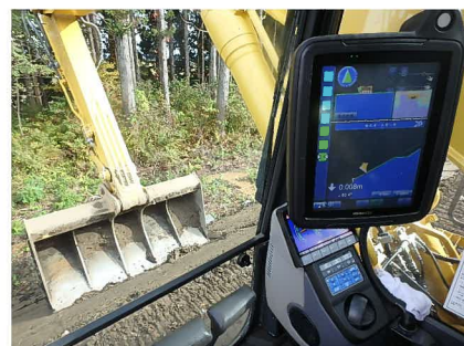
ICT建設機械による施工状況
