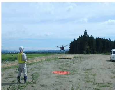
UAVによる起工測量状況
