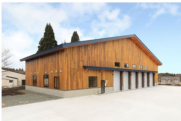
林業研究研修センター 機械実習棟
