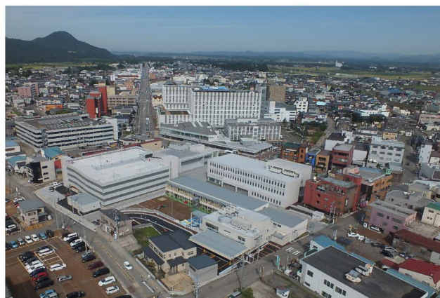
大曲通町地区（全景）
