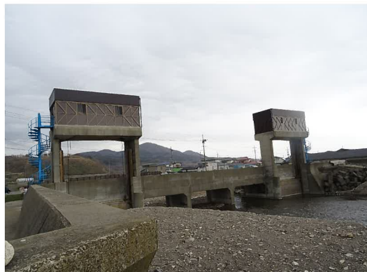
《上屋の更新に伴い、耐震化を実施した水門》 (浜田・八森海岸(泊川水門) 八峰町)
