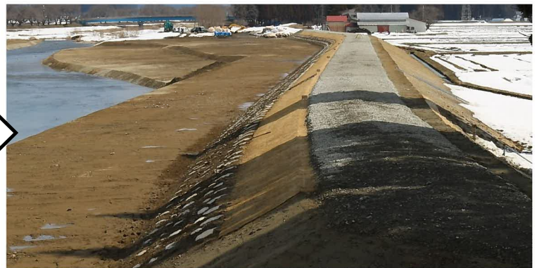
復旧工事完了
