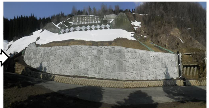
復旧工事完了
