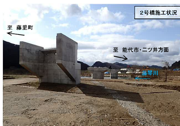
(一) 西目屋二ツ井線 能代市・藤里町 荷上場バイパス
