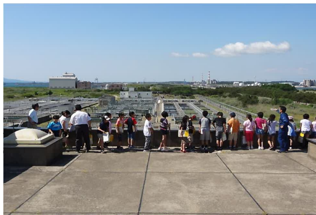
臨海処理センター
