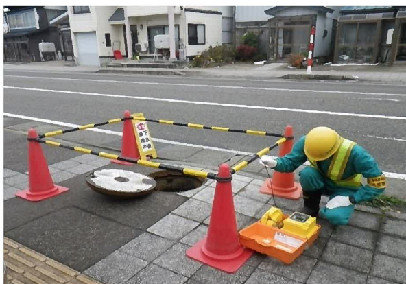
マンホールの点検
