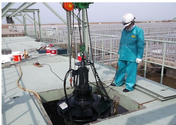
処理施設の点検
