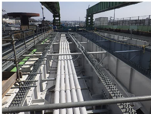
【橋梁の拡幅・耐震補強等による防災性能の向上】 3・4・27千秋広面線 秋田市手形陸橋(JR部 鋼桁設置完了)
