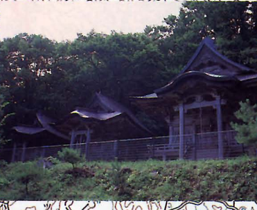
●五社堂 999段の石段にまつわるなまはげ伝説がある。県指定有形文化財で、中央室内厨子は国指定有形文化財である。
