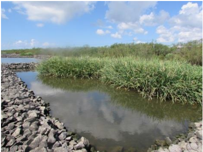
対策実施後(牡丹川河口) ※植生回復が進んでいる
