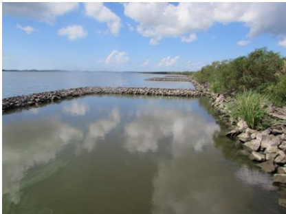
対策実施前(三種川河口) ※植生回復が進んでいない
