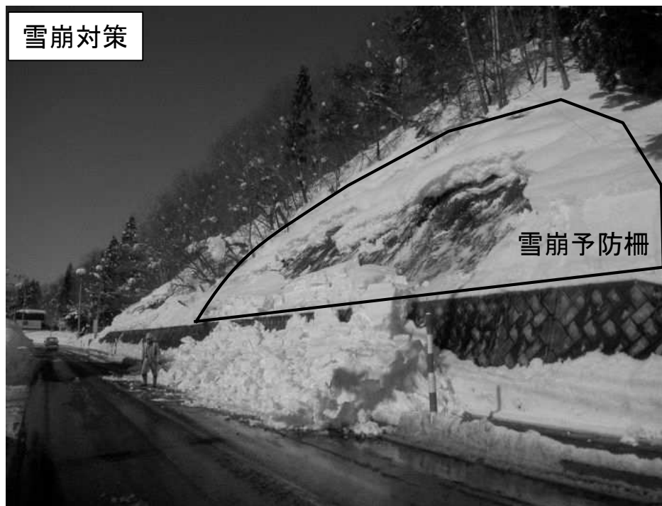
国道398号 山谷工区（湯沢市）
