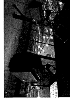
児童会館照明設備(左がボーダーライト、右がピンスポットライト(いずれもS55年製))
