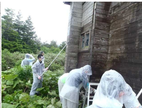
(高所部分はローラーを使用)
