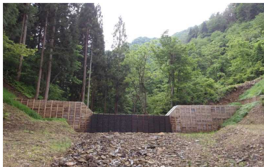
県産木材を使用した土木施設の例（左：治山ダム工、右：土留工）
