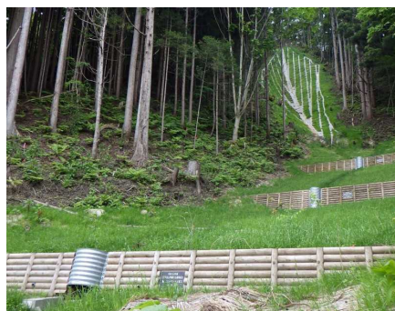
県産木材を使用した土木施設の例（左：治山ダム工、右：土留工）
