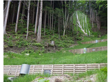
県産木材を使用した 土木施設の例(土留工)
