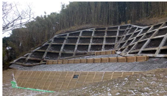
県産木材を使用した土木施設の例（左：治山ダム工、右：土留工）
