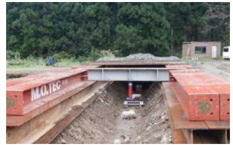
スギ丸太杭載荷試験の状況
