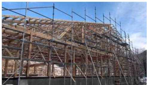
県産スギトラス工法による建築された畜舎
