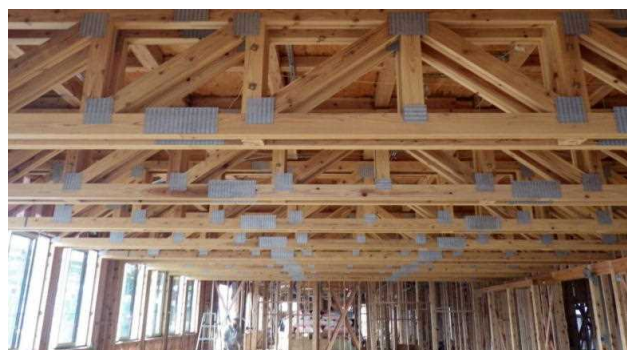
施設内の多目的ホールをスギトラス工法により構成
